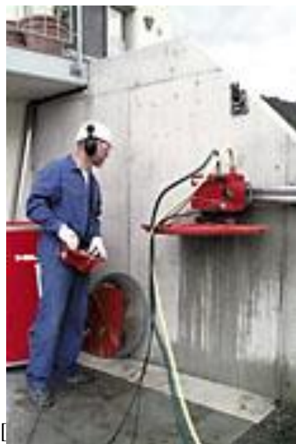
Aperturas de Huecos en Hormigón
